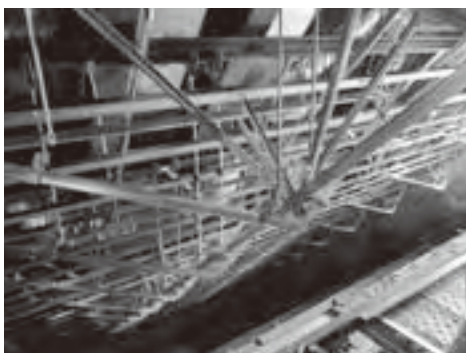
鉄骨下地（田の字組の平面的な部分）
