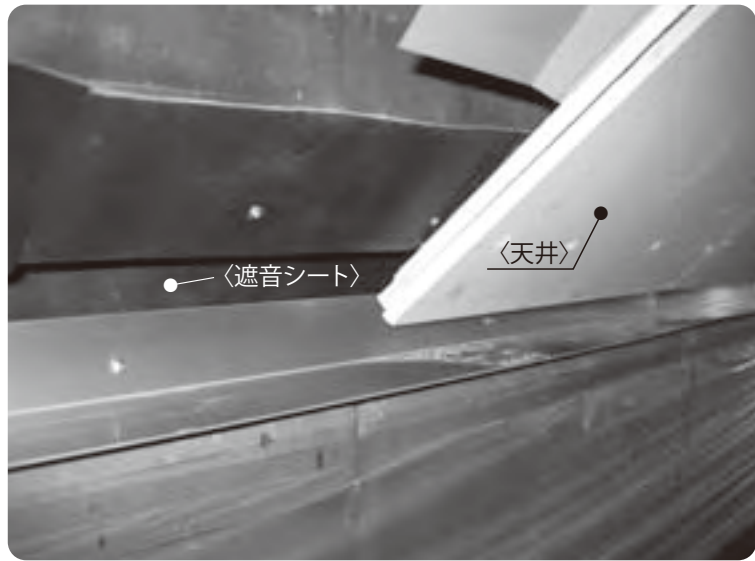
天井と遮音シート
