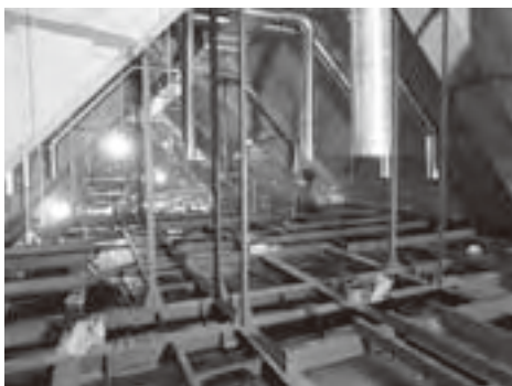
鉄骨下地（田の字組の平面的な部分）
